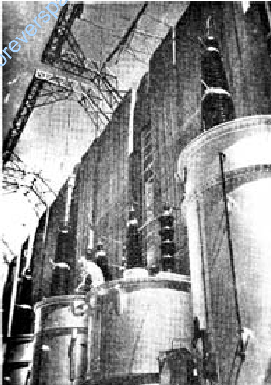
လျှပ်စစ်ဓာတ်အားပေးရုံမှလွတ်သည့် လျှပ်စစ်ဗို့အားကို တိုးမြှင့်ပေးသော ထရန်စဖေးမားကြီးများ
